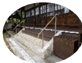
観音堂手摺設置
