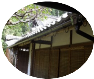
客殿雨樋取替修理
